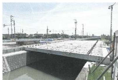
設置された堀川橋梁上部(令和4年5月)
