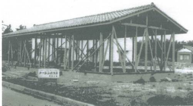
昭和43年に建築中の中間確認検査用写真
