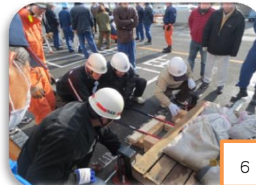
中間の支点の滑車で、チルホールの牽引方向と重量物の移動方向を変える
