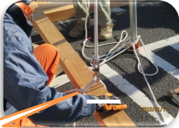
滑車付き三脚ポールを使った重量物の引き上げとロープの結び方
