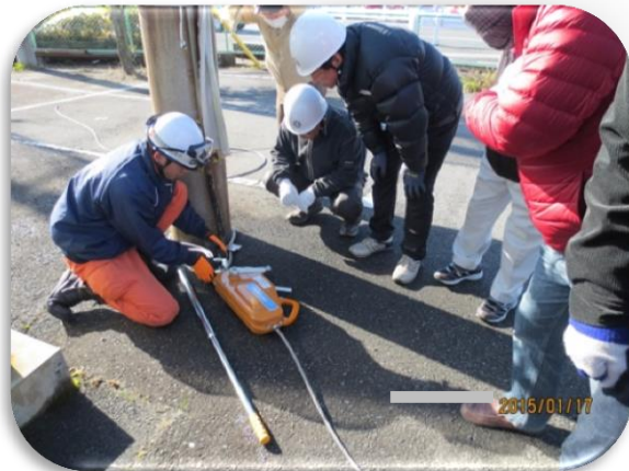
牽引器具 チルホール による重量物 の移動
