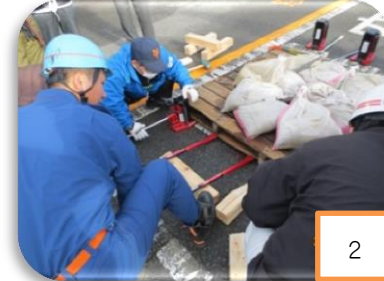
ボール・爪付きジャッキ・ 角材を使った重量物の 持ち上げ
